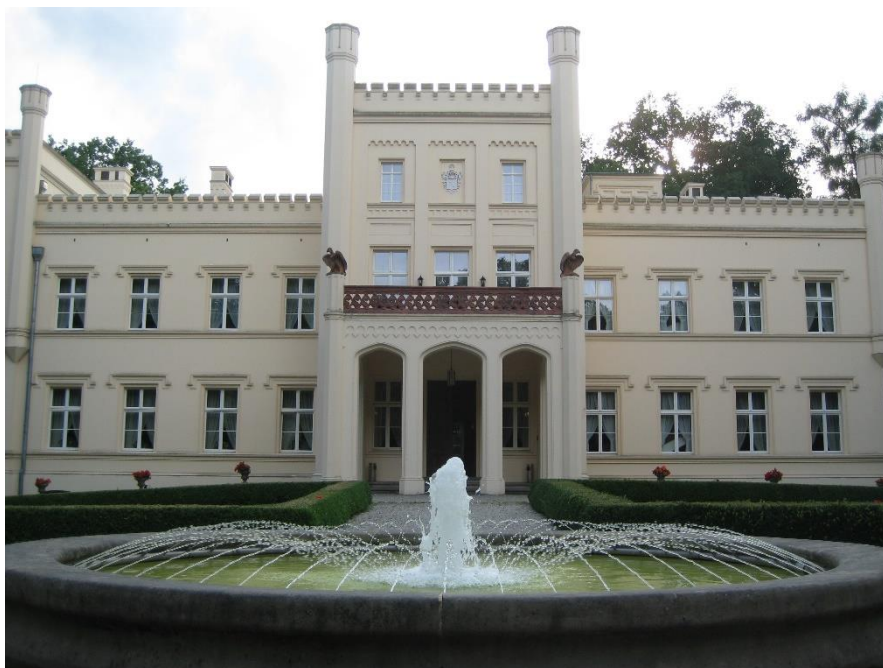
Fot. 1. Pałac w Mierzęcinie, źródło: fotografia własna
